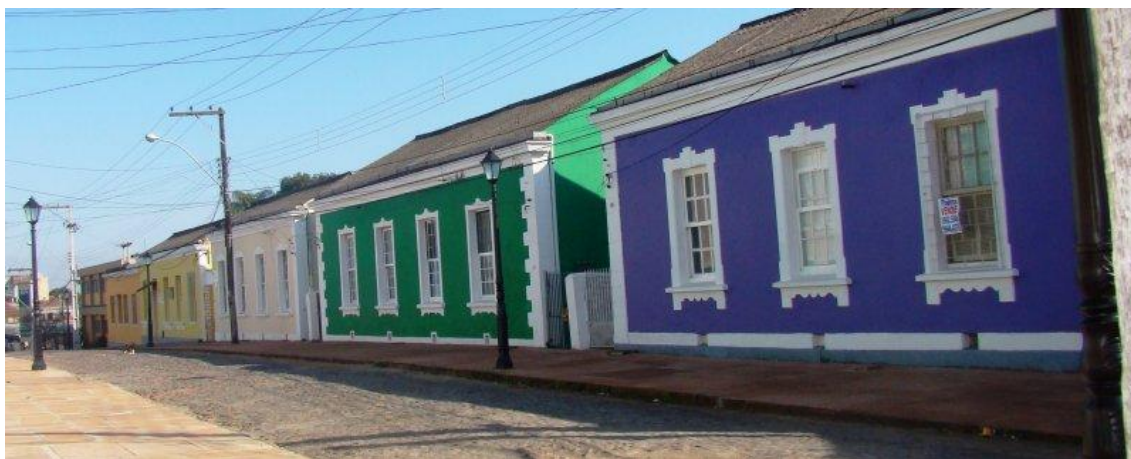
Figura 03: Vila Belga após intervenções em 2010. Fonte: Prefeitura Municipal de Santa Maria (2010).
