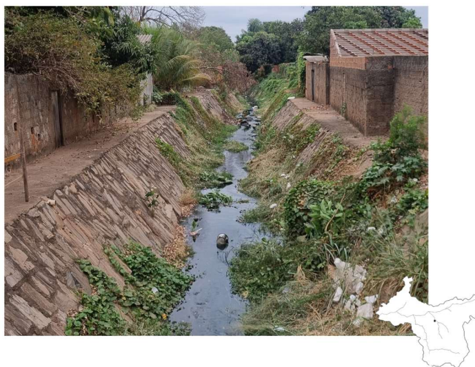
Figura 2: Canalização do Córrego Machado no Residencial Coxipó
