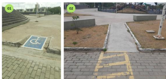
Figura 14- Rebaixamento das Calçadas da Praça dos Bichos
