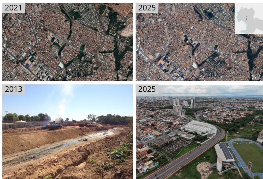
Figura 3 e 4: imagens de satélite da Av Parque do Barbado (acima) e perspectivas de sua fase de execução (esquerda inferior) e atualmente (direita inferior)
