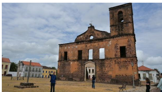
Figura 3: Ruínas da Igreja Matriz
