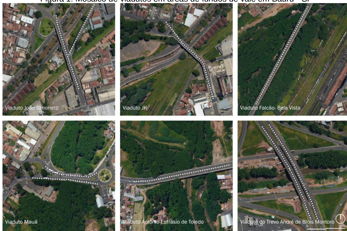
Figura 1: Mosaico de viadutos em áreas de fundos de vale em Bauru - SP
