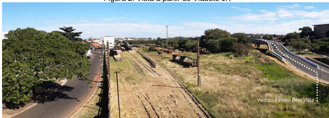
Figura 2: Vista a partir do Viaduto JK
