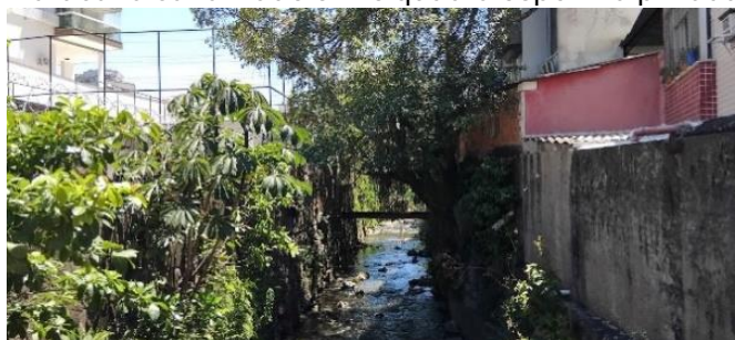
Figura 4: Rio Maracanã canalizado entre quadra esportiva privada e habitações
