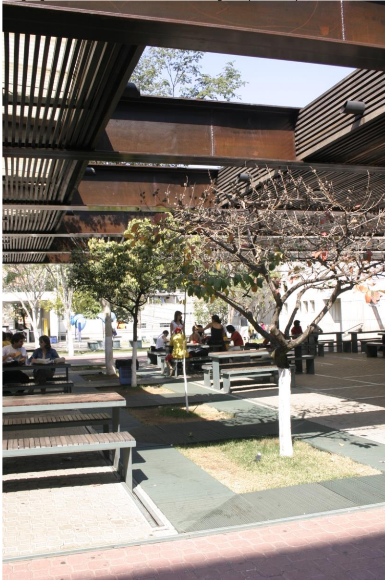
Figura 07 - Fotografia mostrando as aberturas zenitais na cobertura do centro de convivência e as gárgulas de direcionamento das águas pluviais para as árvores.
