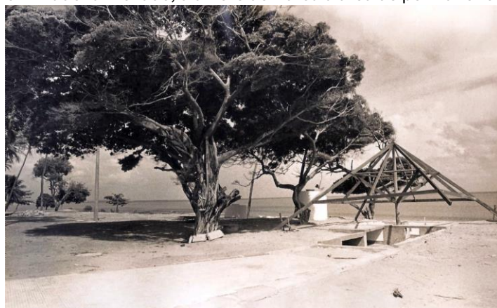
Figura 8: Quiosque em construção, 1979. Percebe-se a sua base semienterrada e a estrutura da coberta em madeira. Ao lado, a árvore demarca a área de permanência criada.
