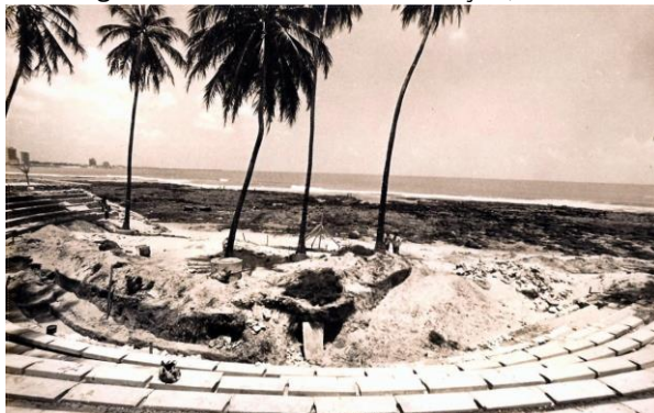
Figura 7: Anfiteatro em construção, 1979.
