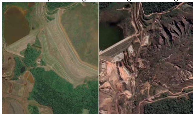
Figura 1: Antes e depois da região da barragem do Córrego do Feijão.
