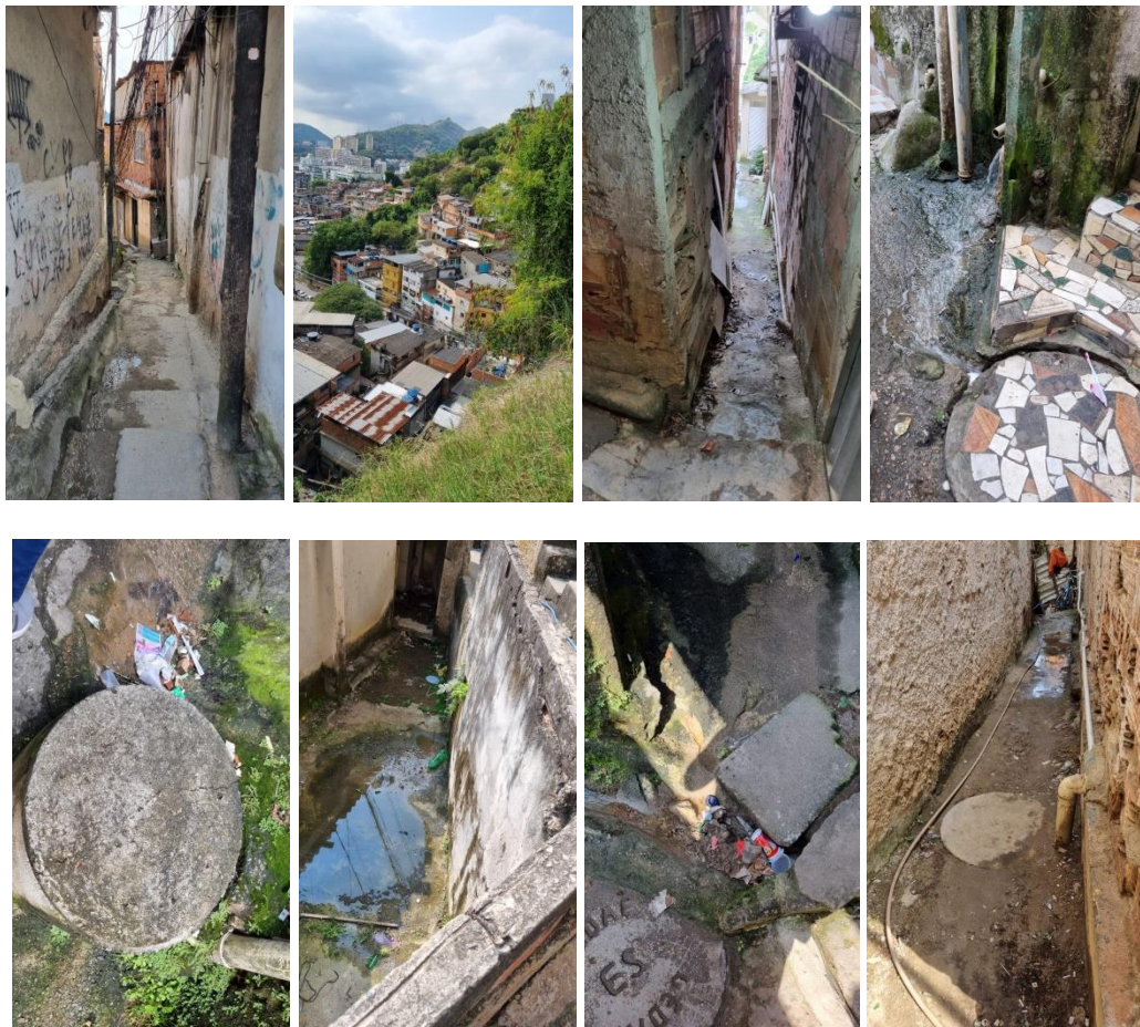
Viela com água escorrendo; desníveis na comida; outra viela com água escorrendo; esgoto transbordando; lixo jogado; esgoto escorrendo; tampas de fossa quebradas; esgoto escorrendo – fotos minhas
