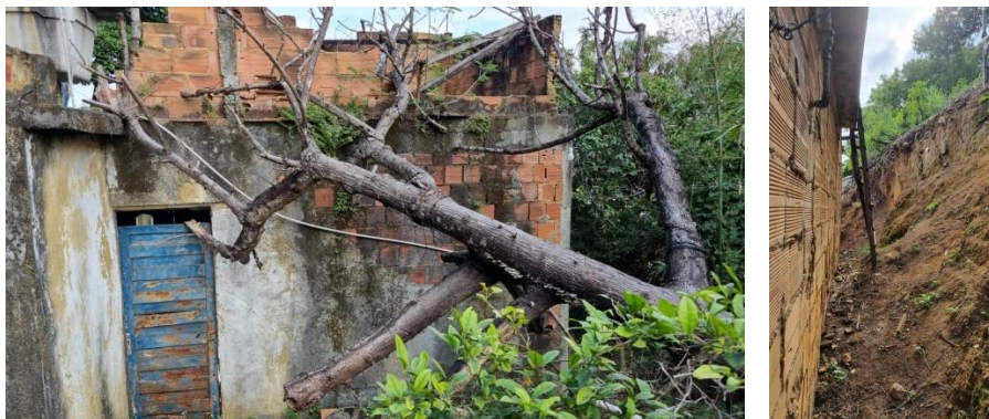
Vazamento; tampa de fossa quebrada e com entulhos; canos saindo casa em construção; árvore tombada sobre casa; casa condenada pela Defesa Civil – fotos minhas.
