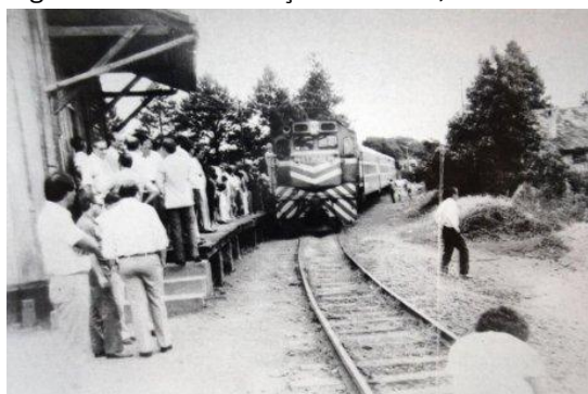
Figura 6: Vista da Estação Oficinas, 1980
