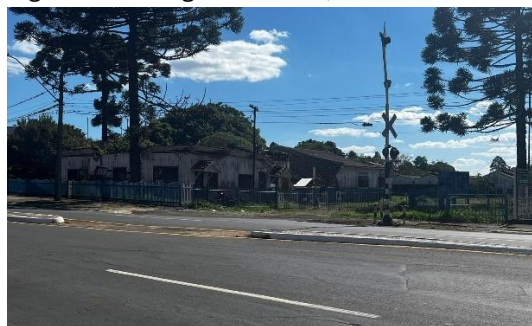
Figura 9: Passagem de nível, 2025
