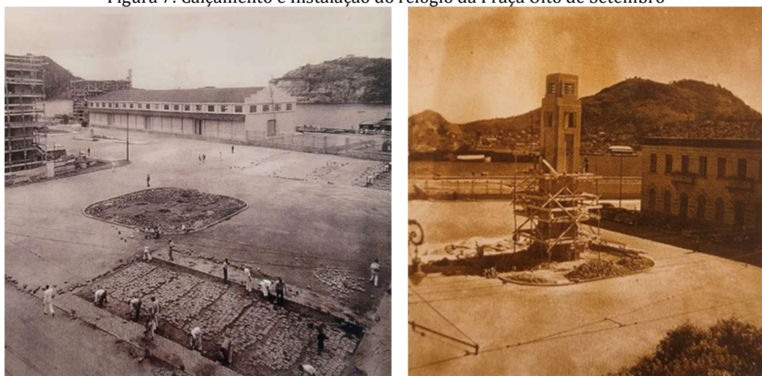
Figura 7: Calçamento e Instalação do relógio da Praça Oito de Setembro
