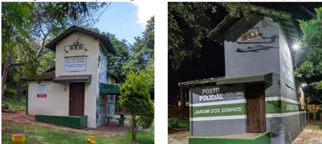
Figura 1: Transformação da antiga sede da AMOR em Posto policial (antes e depois)
