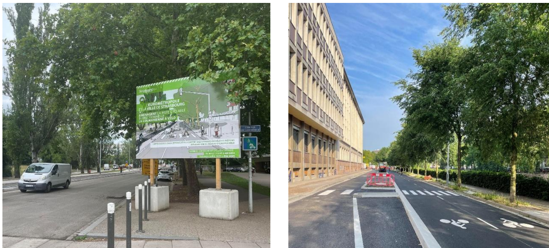
Figura 9: Placa de identificação de projeto (à esquerda) e obra em curso (à direita), ambos com foco na rede cicloviária.
