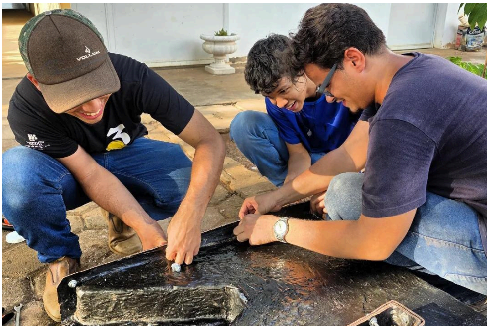
Figura 1- Alunos do IFNMG-Campus Pirapora executando um banco de concreto
