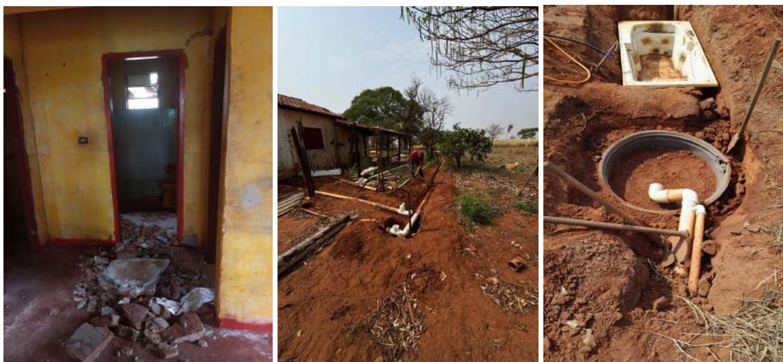
Figuras 6,7 e 8 - Construção do sistema ecológico para tratamento de esgoto.
