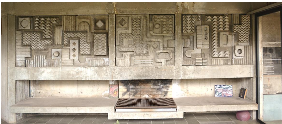
Figura 7: Painel em concreto (armário) na sala de estar da residência – autoria de Burle Marx.
