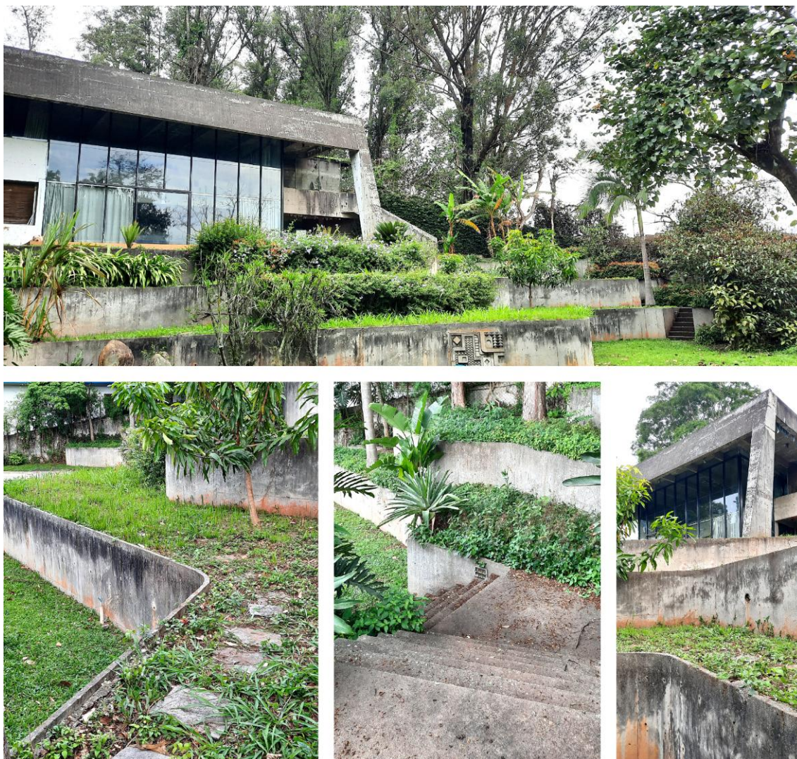
Figura 9: Platôs curvilíneos criados a partir do desnível topográfico do terreno.
