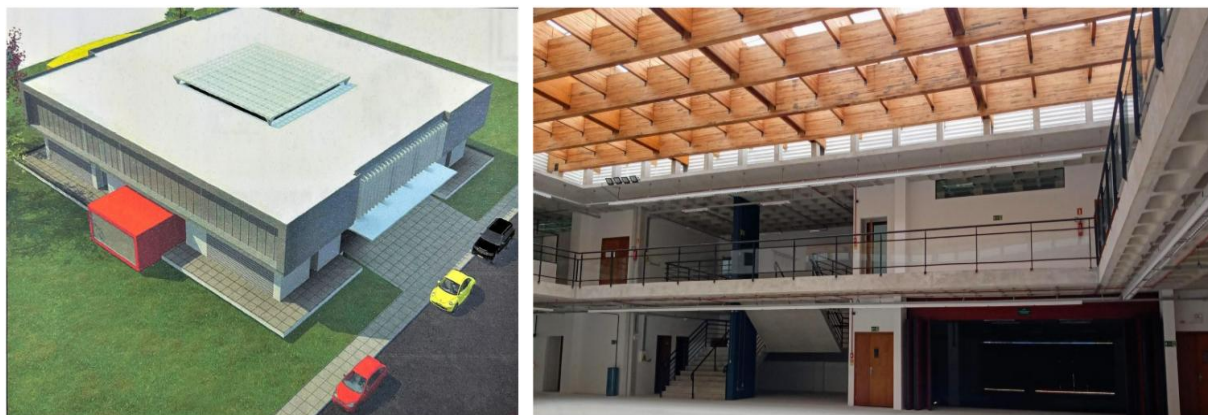
Figura 1: Partido com estrutura em aço e obra com madeiramento. Fonte: Acervo LAEDPA (2012) e acervo da empresa Esmara (2019).
