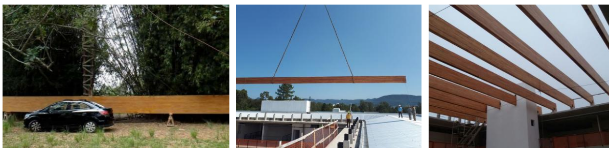
Figura 3: Vigas e instalação. Fonte: Acervo Esmara e PROINFRA (2018).
