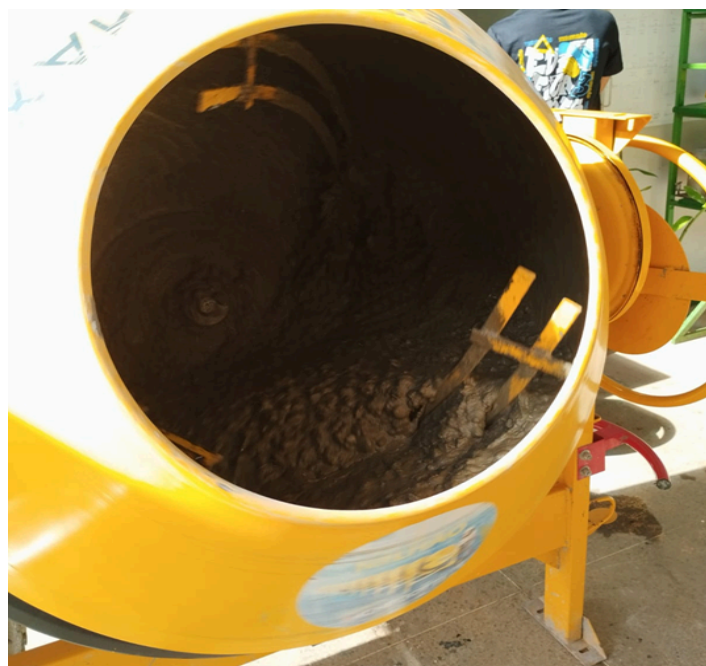
Figura 02 – Preparo do concreto
