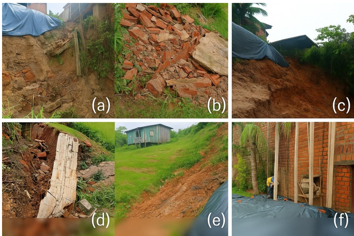
Figura 1. Ocorrências geotécnicas identificadas nos relatórios da Defesa Civil de Cruzeiro do Sul (2021–2025): (a) deslizamento de talude; (b) colapso de muro em alvenaria; (c) talude exposto e instável; (d) colapso parcial de contenção; (e) moradia precária em área suscetível; (f) contenção improvisada junto a edificação.
