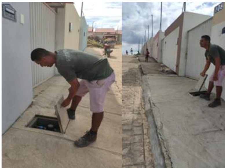
Figura I – instalação das caixas de água que ligam as casas aos poços
