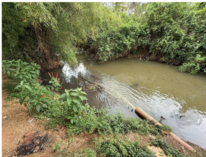
Figura 2 - local de escoamento de águas residuais
