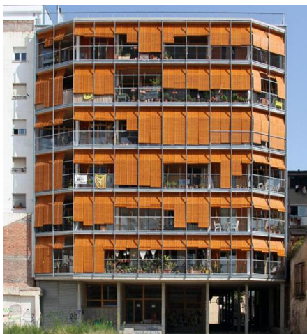
Figura 5 – Fachada do projeto La Borda, Barcelona.
