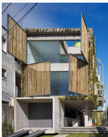
Figura 7 – Fachada do projeto Harmonia 57, São Paulo. Fonte: OLIVEIRA, 2018
