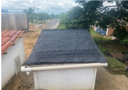
Figura 4 - Execução da camada filtrante
