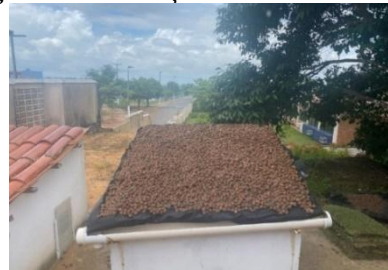
Figura 3 - Execução da camada drenagem
