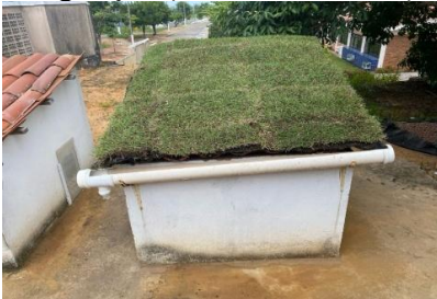
Figura 6 - Execução da camada de vegetação (Grama Esmeralda)
