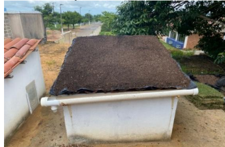
Figura 5 - Execução da camada de substrato
