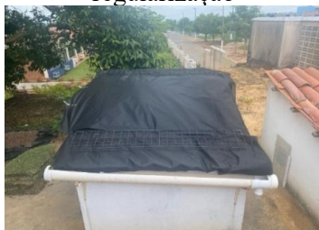
Figura 2 - Execução da camada de regularização
