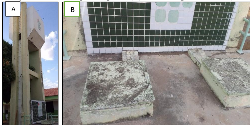
Figura 2 – Cisterna parte superior (A) e Cisterna parte inferior (B)
