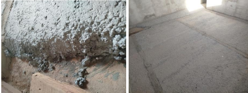
Figura 01: Mistura utilizada para o contrapiso e contrapiso com Poliestireno Expandido (EPS) finalizado.
