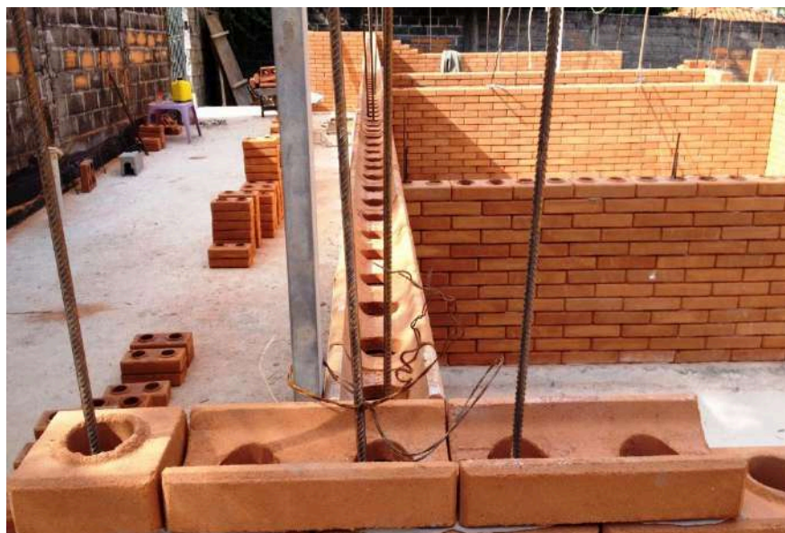
Figura 27 - Obra em execução feita com tijolo ecológico.
