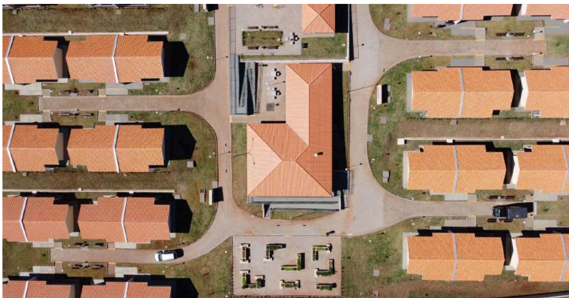
Figura 2 - Imagem aérea da implantação do condomínio do idoso de Foz do Iguaçu, PR, com foco no núcleo central.
