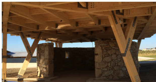
Figura 04: Centro Equestre / Carlos Castanheira & Clara Bastai - Área para banho dos cavalos
