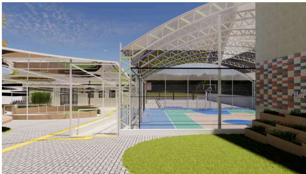
Figura 44 - Rampa e quadra de esportes com cobertura de policarbonato alveolar
