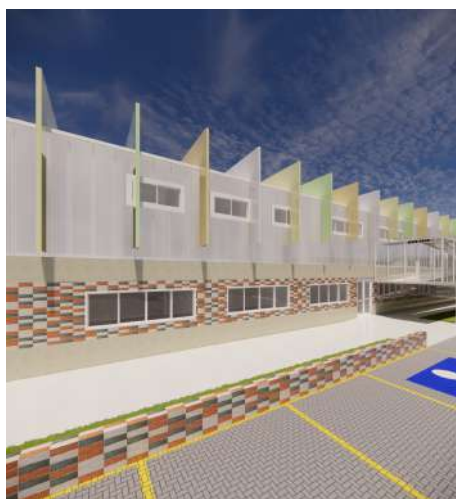
Figura 39 - Placas de policarbonato e revestimentos aplicados
