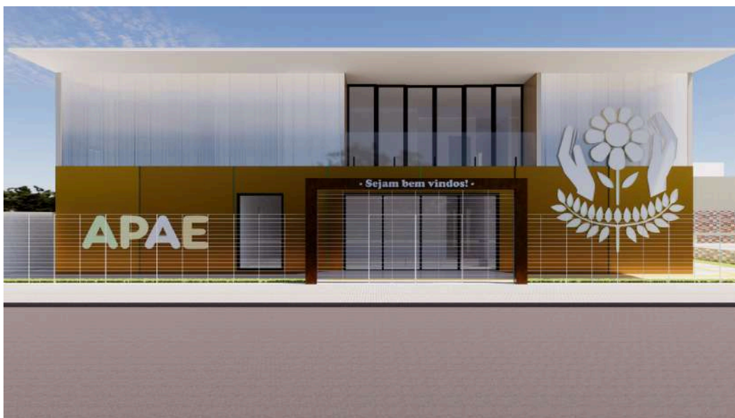
Figura 41 - Fachada com painéis e logo em ACM
