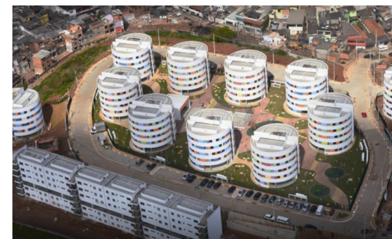
Conjunto Habitacional Redondinhos. Fonte: ArchDaily
