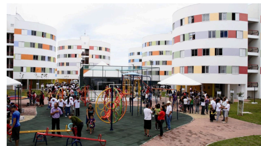
Conjunto Habitacional Redondinhos. Fonte: ArchDaily
