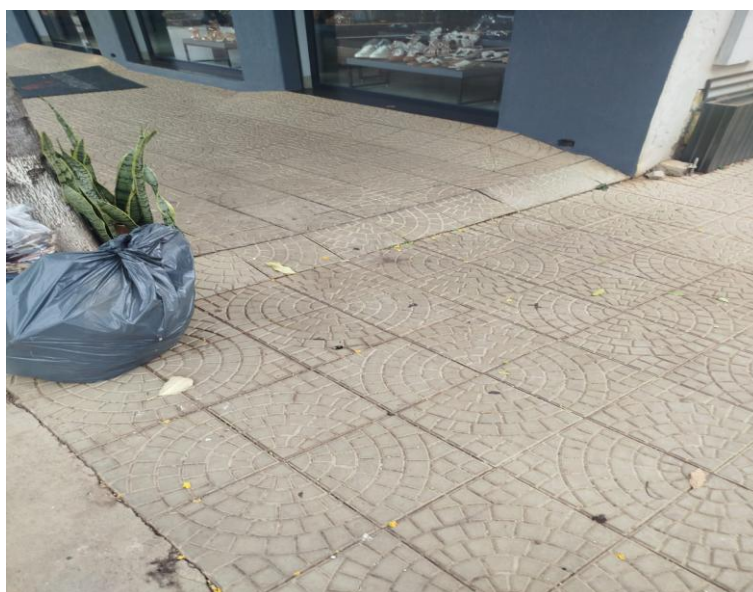
Figura 12 - Rampa/Desnível na calçada.
