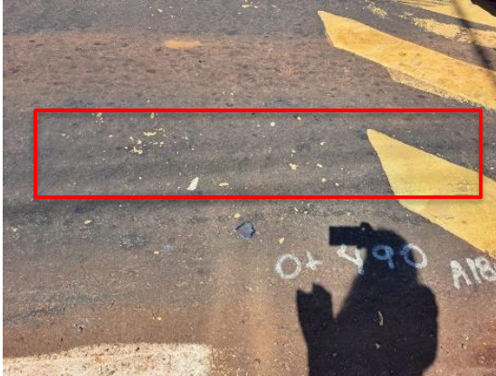
Figura 42 – Afundamento
