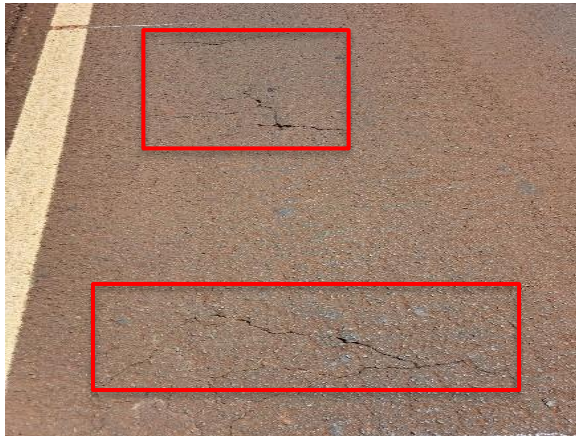
Figura 32 – Trincas transversais
