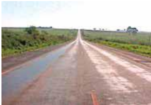
Figura 6 – Desgaste por exsudação
