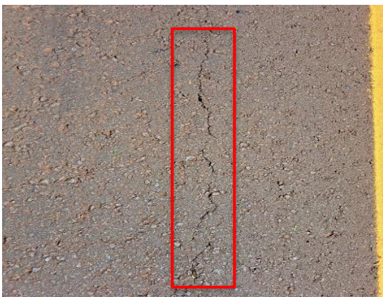
Figura 20 – Trinca longitudinal
