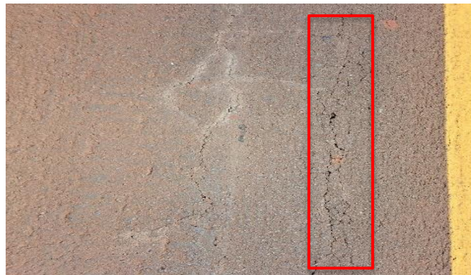
Figura 40 – Trinca longitudinal
