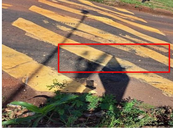
Figura 43 – Afundamento
