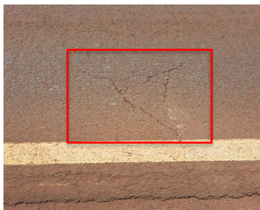
Figura 37 – Trincas interligadas
