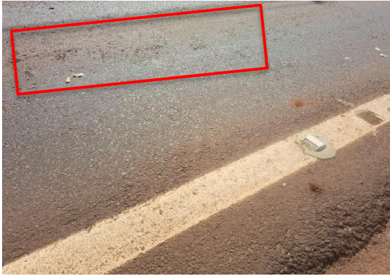
Figura 18 – Trinca longitudinal
