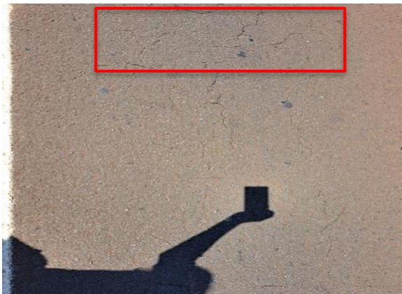
Figura 36 – Trincas interligadas
