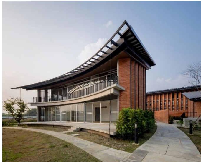
Figura 2 – Imagem de uma das edificações
