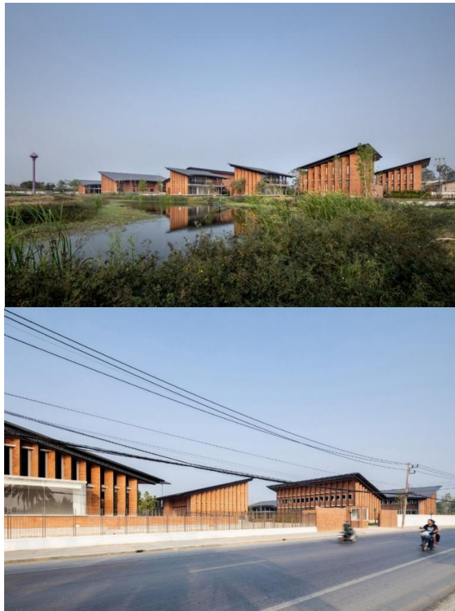
Figura 1 – Imagens do conjunto das edificações
