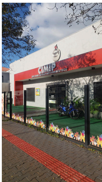
Imagem 11 - Fachada clínica CIMIP
