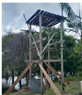
Figura 4. Local onde será instalado os sensores. Fonte: Autores
