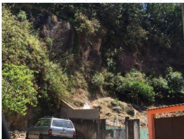
Figura 3 - Área de risco de deslizamento em Santa Rita do Sapucaí.
