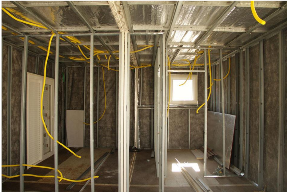
Figura 3 – instalações elétricas e hidrossanitaria de uma construção em container
