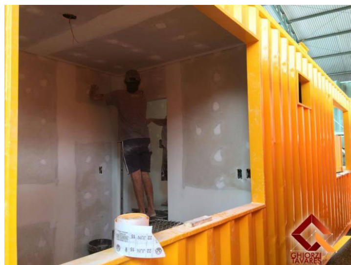
Figura 2 – finalização do processo de aplicação do drywall
