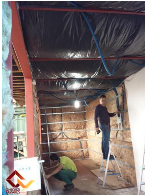
Figura 1 – inserção da camada de isolamento térmico-acústico entre a chapa de aço e a camada de drywall que será aplicada posteriormente
