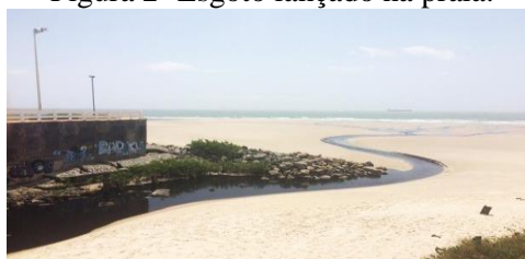
Figura 2- Esgoto lançado na praia.
