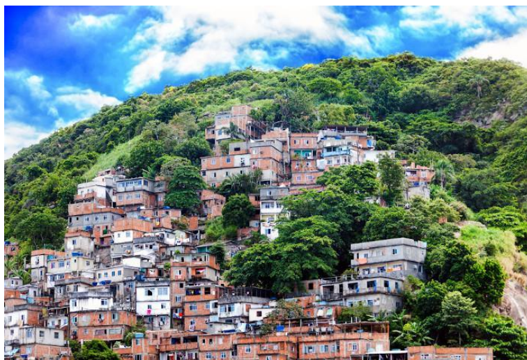
Figura 1. exemplo da favelização: a ocupação de áreas naturais inadequadas
