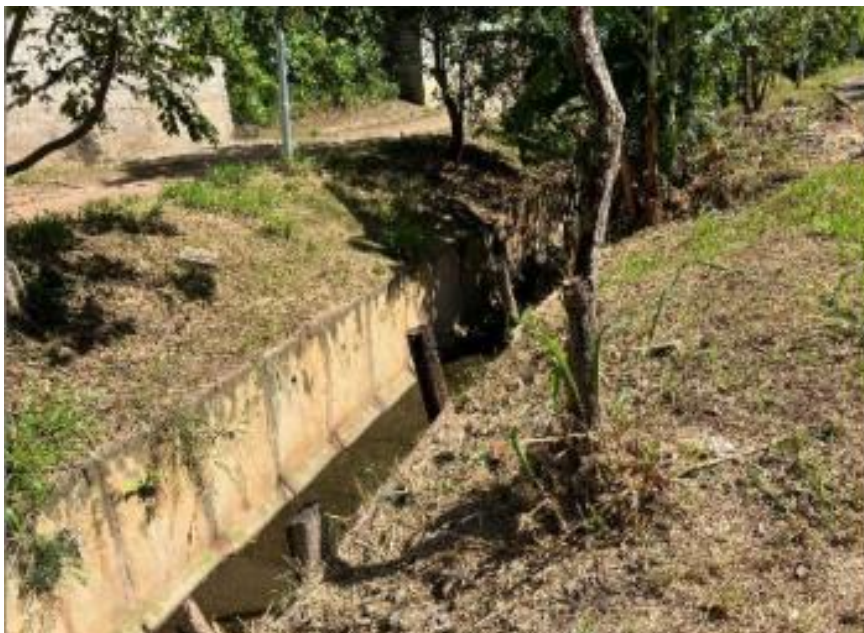
Figura 3: Canal aberto revestido por concreto – Rua Pedro Francisco dos Santos, Taubaté
