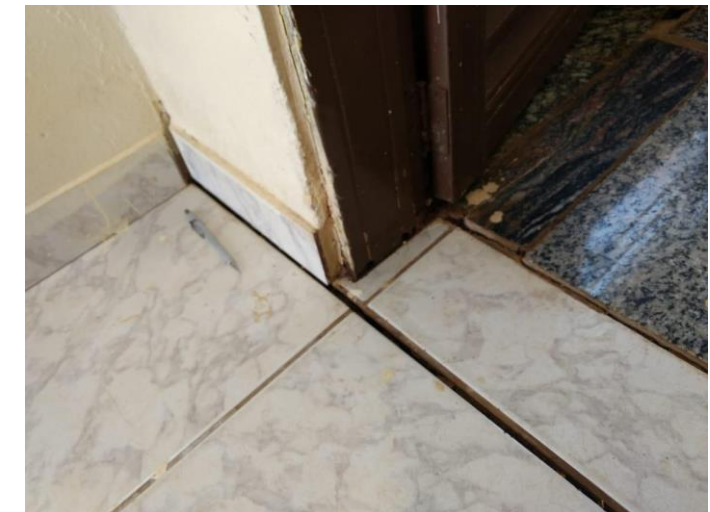
FIGURA 2 - RECALQUE
