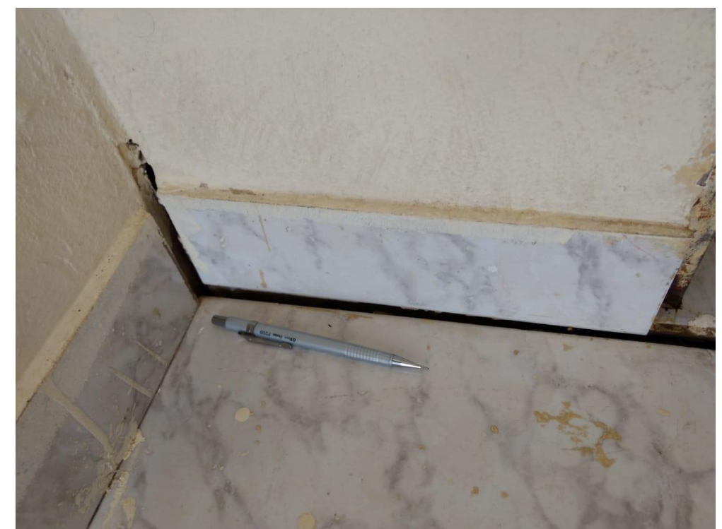
FIGURA 3 - RECALQUE
