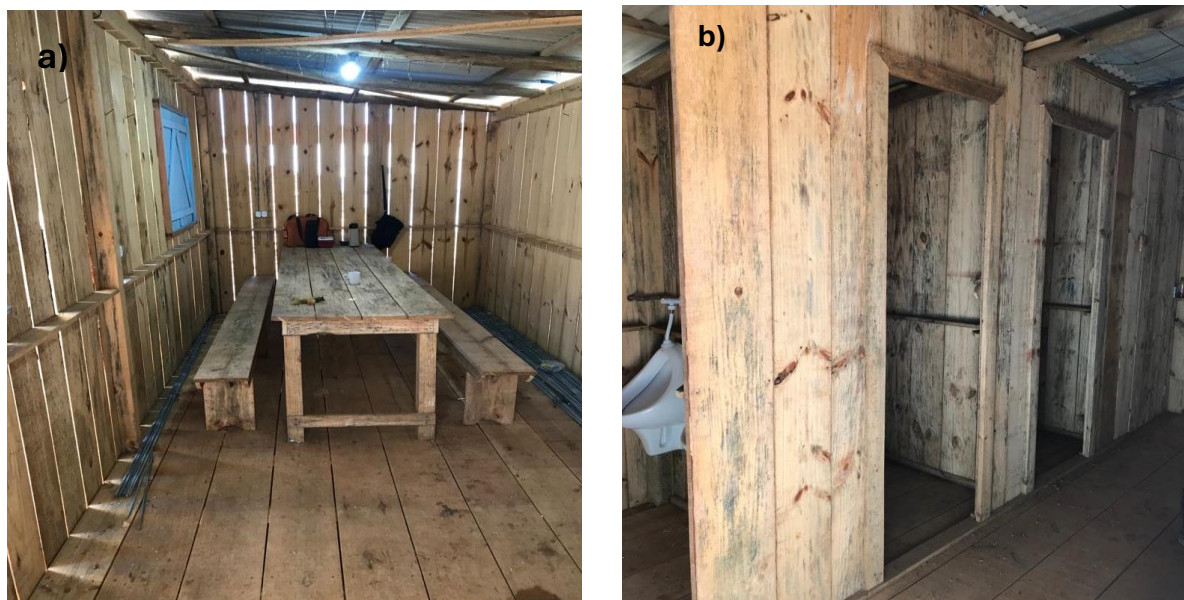
Figura 6- Partes interna da área de vivência: a) parte interna refeitório, e b) parte interna do vestiário
