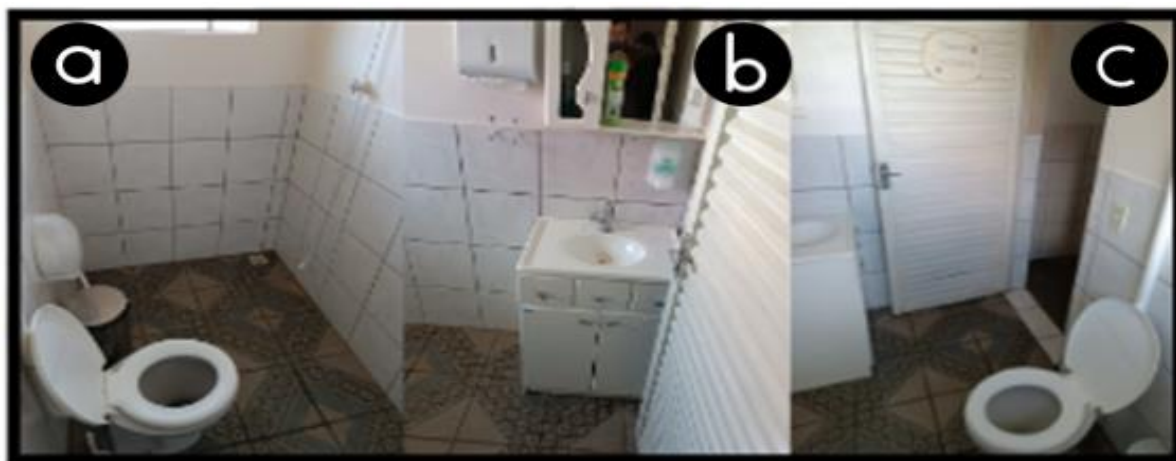
Figura 3 - Banheiros da Instituição em estudo
