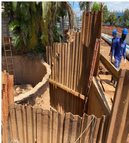
Foto 03 – Utilização de escoramento metálico com sistema de travamento, , disposição de escada para acesso. Fonte: autor
