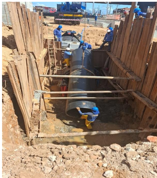
Foto 04 – Utilização de escoramento metálico com sistema de travamento, disposição de escada para acesso, uso de EPI's específicos para atividade. Fonte: autor
