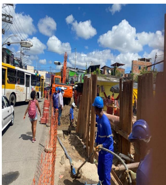
Foto 05 – Utilização de escoramento metálico com sistema de travamento, instalação de esgotamento sanitário, delimitação de perímetro da intervenção com utilizando tela de sinalização, uso de EPI's pela equipe de trabalho. Fonte: autor
