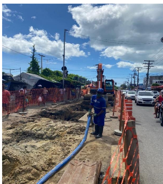
Foto 04 – Utilização de escoramento metálico com sistema de travamento, disposição de escada para acesso, uso de EPI's específicos para atividade. Fonte: autor
