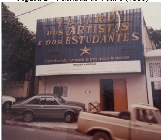
Figura 2 – Fachada do Teatro (1986)
