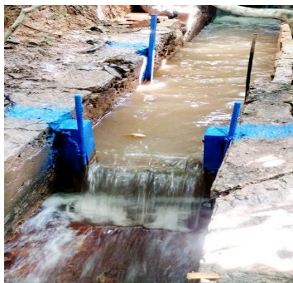
Figura 1 – Sistema de vertedouro para monitoramento de perdas
