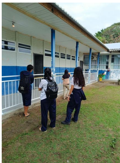
Figura 1: Medição da área do bloco da escola onde será instalado sistema de captação de água com o intuito de estimar a área do telhado.
