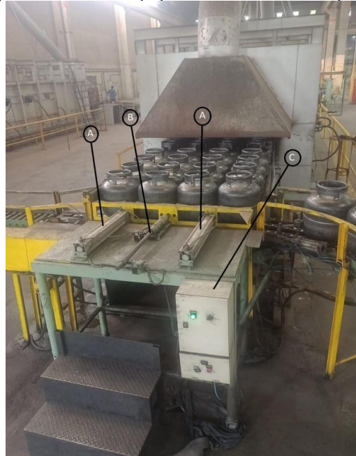
Figura 2 – (A) Cilindros pneumáticos; (B) Guia mecânica; (C) Painel elétrico.
