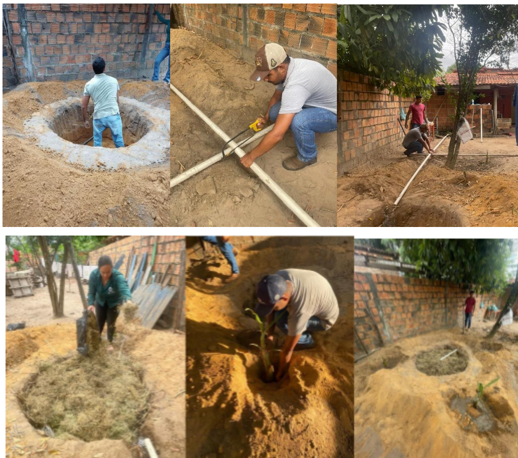
Figura 2- Implantação do sistema de fossa ecológica: Círculo das Bananeiras.
